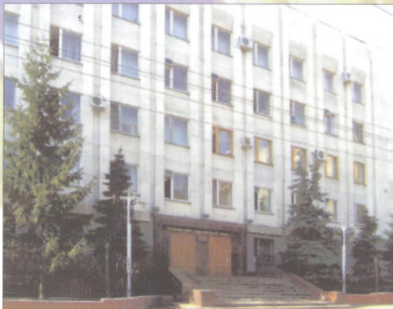
Современное здание прокуратуры Саратовской области. Ул. им. Е.Ф. Григорьева, 33/39.
