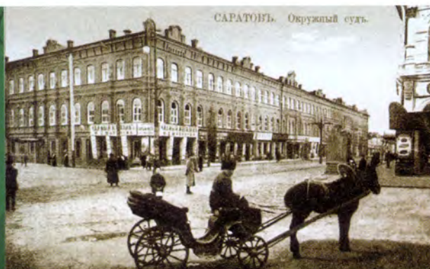
Здание судебной палаты и окружного суда на углу улиц Московской и Никольской (ныне Радищева). Построено в 1878 году по проекту архитектора А. М. Салько
